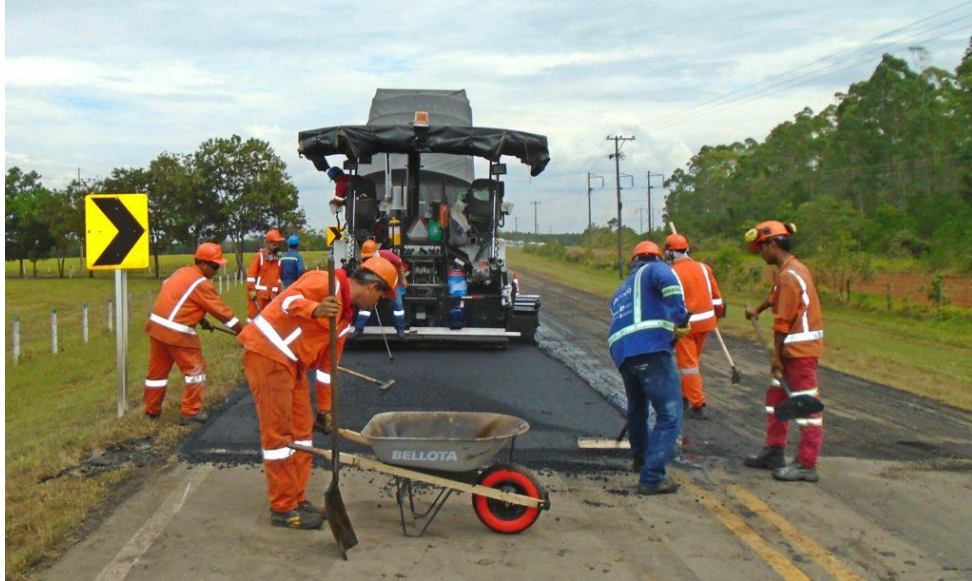
Imagen 12.construccion vial, vía del Meta
