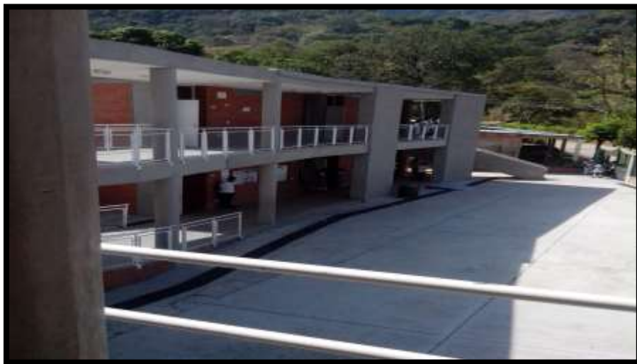
Figura 12. Infraestructura I.E.D Pueblo Nuevo FUENTE: Propia
