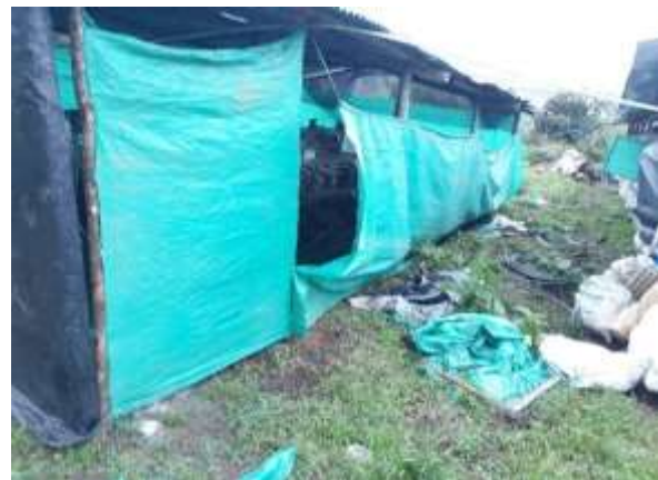
Imagen No.10 galpón 3 adecuación puerta y poli sombra
