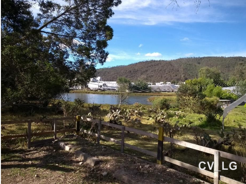
Reservorio de agua lluvia (22.000 m 2 y 1 mt de profundidad)
