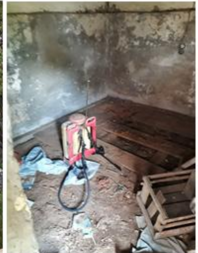
Bodega de insumos
