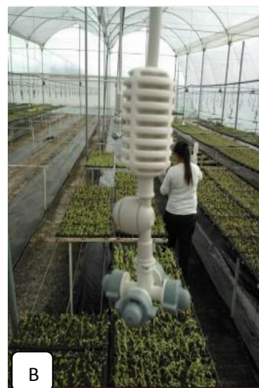
Figura 11. Componentes del umbráculo. A: ubicación, B: Sistema de riego por goteo y nebulización,. Fotografías tomadas por Eliana Duarte 2019
