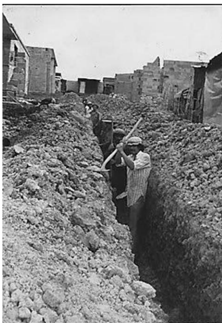
Fotografía 1-6: Construcción comunitaria del acueducto del barrio Popular Obrero.
