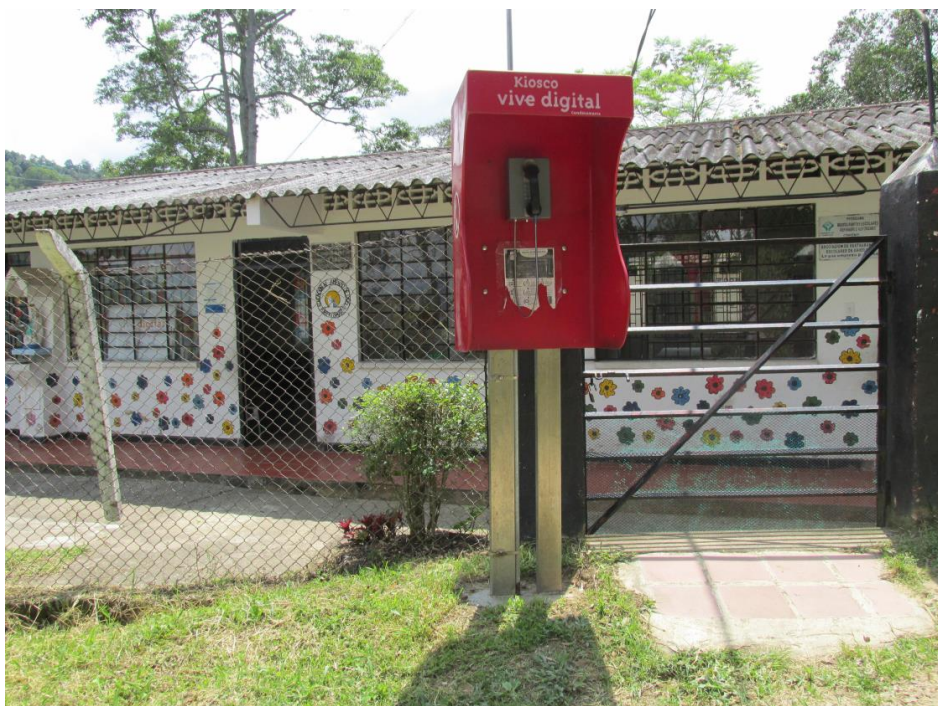
Imagen 1: Vista frontal de la escuela la Honda en Arbelaez - Cund. Fuente propia
