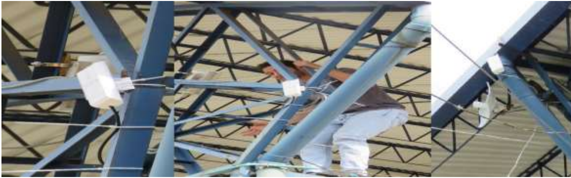
Figura N° 49: Instalación nodos (Autor).
