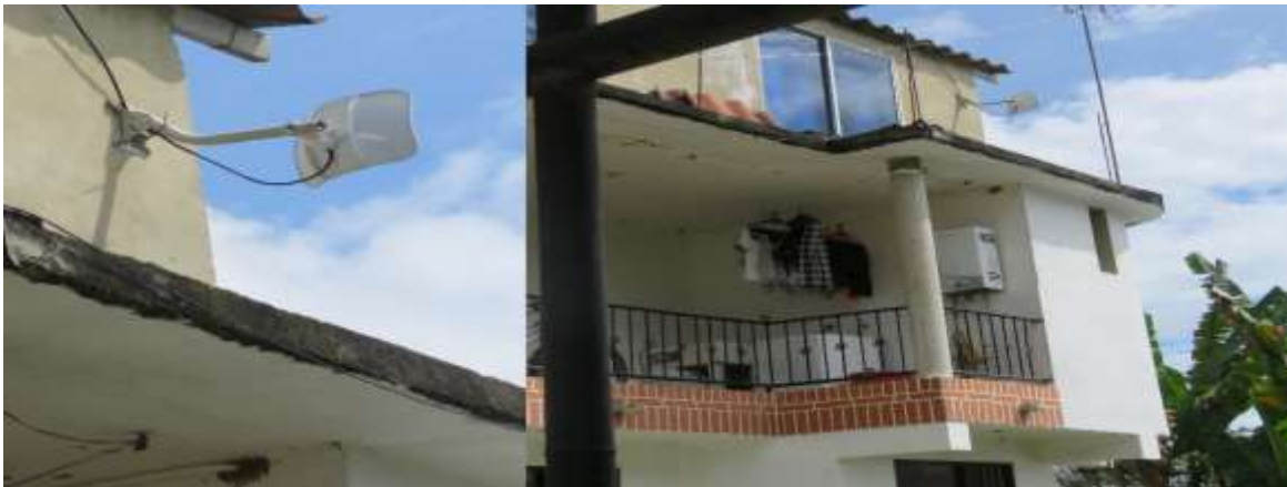
Figura N° 36: Instalación estación Comunidad Don Ángel (Autor).
