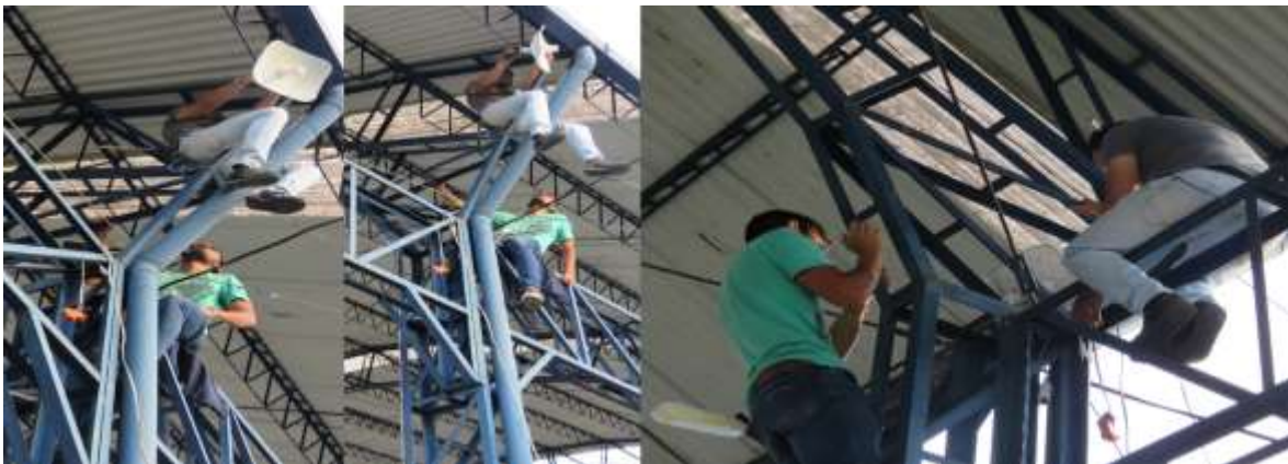
Figura N° 48: Instalación estación (Autor).
