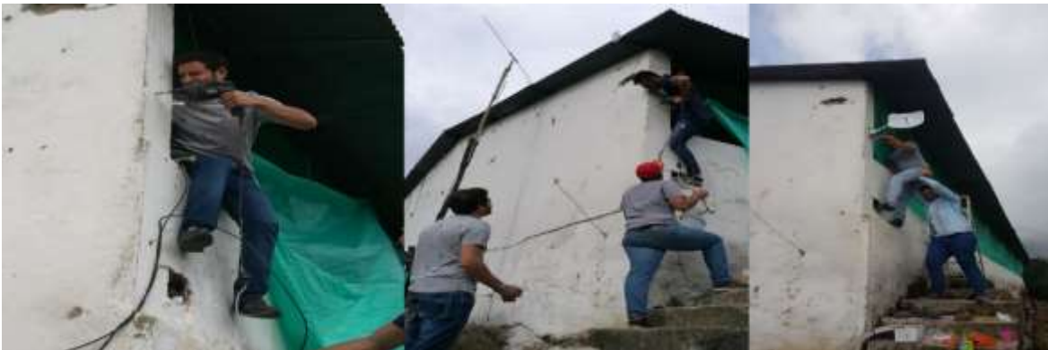
Figura N° 40: Instalación estación nodos Comunidad Doña Lucero (Autor).
