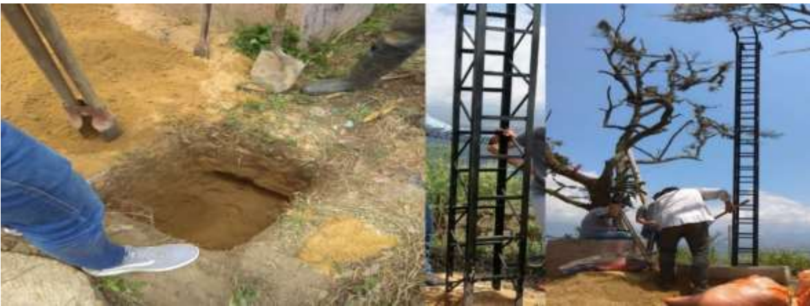
Figura N° 12: : Instalación y adecuación Cercha, enlace PTP San José (Autor).
