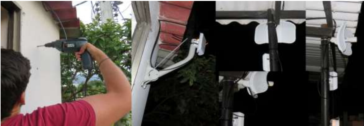
Figura N° 44: : Instalación nodos Comunidad Don Manuel (Autor).
