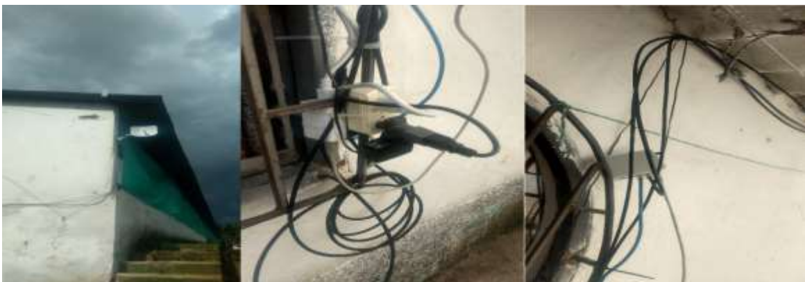
Figura N° 41: Instalación puente nodos Comunidad Doña Lucero (Autor).
