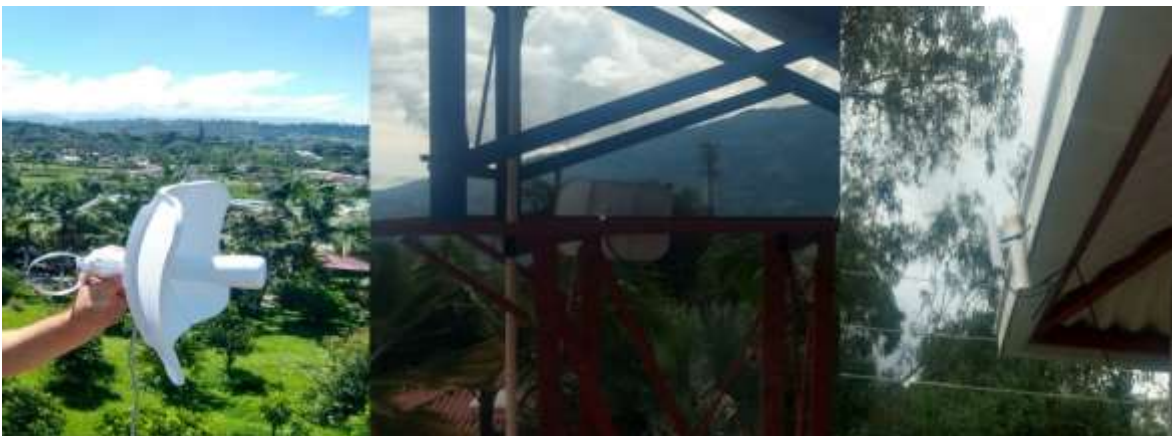
Figura N° 50: Instalación, verificación de estación y nodo (Autor).
