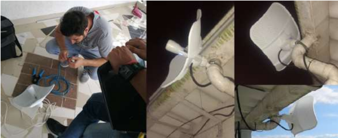
Figura N° 42: Instalación puente nodos Comunidad Don Mario (Autor).
