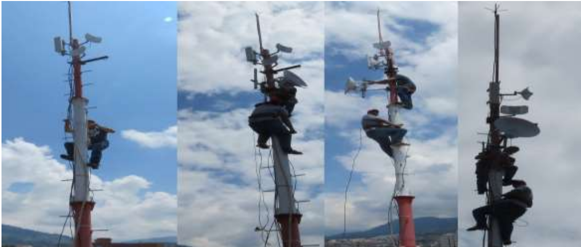
Figura N° 11: Instalación y adecuación antena Bloque F (Autor).
