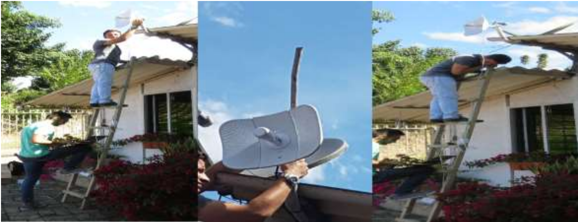
Figura N° 45: Instalación y verificación estación Cartodromo(Autor).
