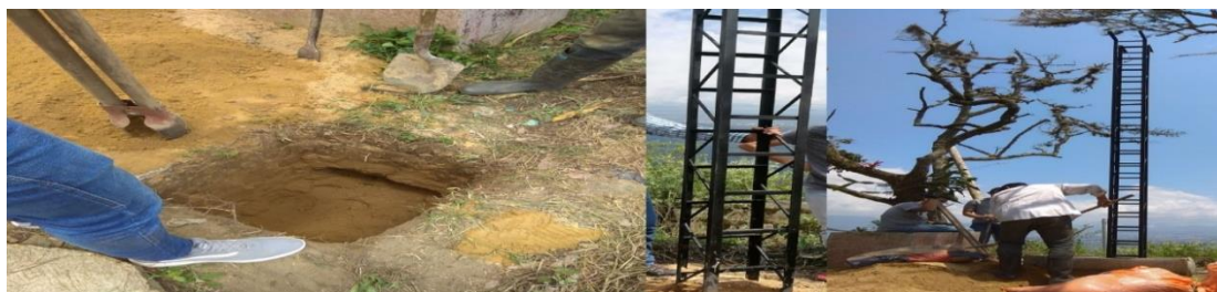
Figura N° 11: : Instalación y adecuación Cercha, enlace PTP San José (Autor).
