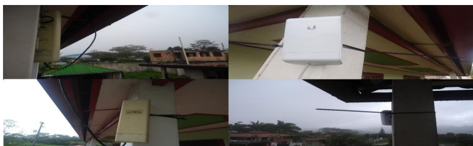
Figura N° 33: Instalación Nodos Comunidad Ángela (Autor).
