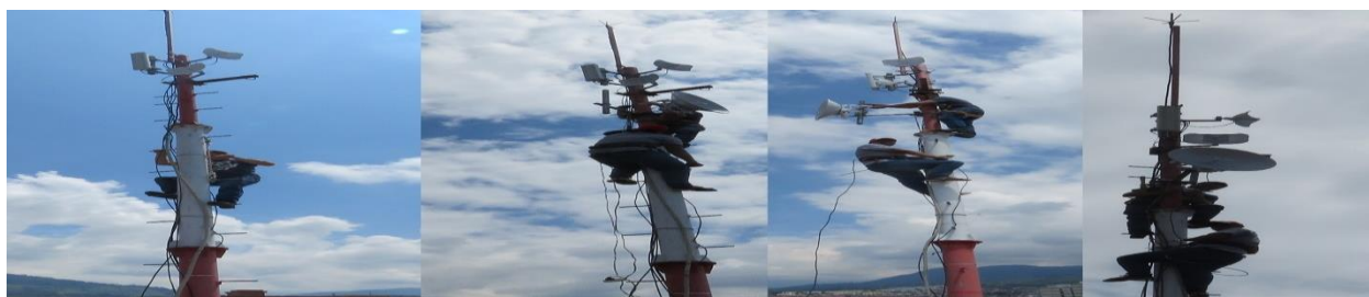
Figura N° 10: Instalación y adecuación antena Bloque F (Autor).
