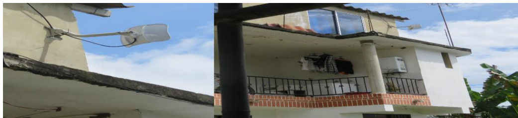
Figura N° 35: Instalación estación Comunidad Don Ángel (Autor).
