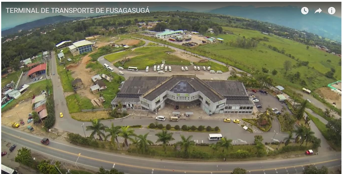
Fuente Archivo Terminal de Transportes
