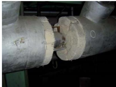
Figura A1.30 Detalle de calorifugado (coquilla)
