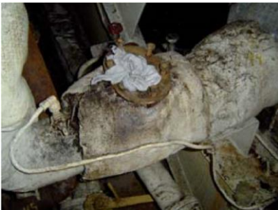
Figura A1.29 Detalle de calorifugado (textiles)
