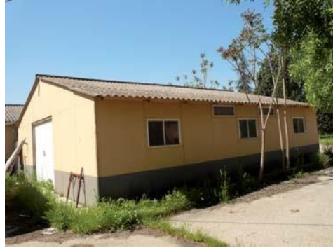
Figura A1.19 Edificios prefabricados (paredes y cubierta)
