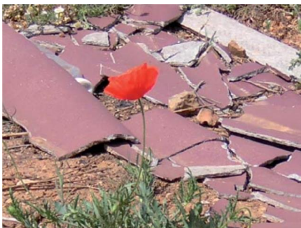
Figura A3.27b Residuos incontrolados de fibrocemento
