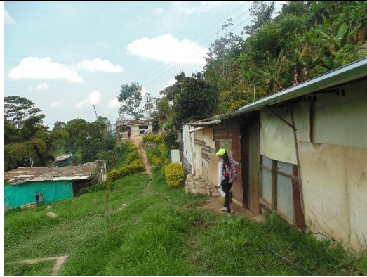
Vereda Pekín – condiciones de saneamiento de los residentes en las partes bajas de la vereda Tomada el 27 de Marzo del 2016
