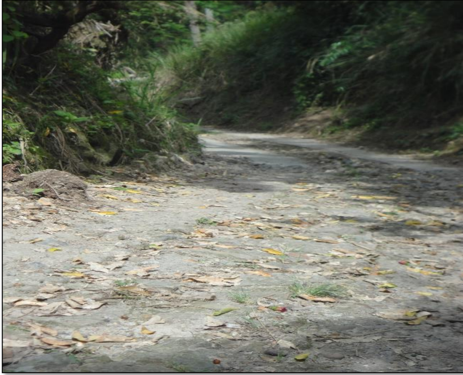
Fotografía 3. Ruta 1, vía carreteable
