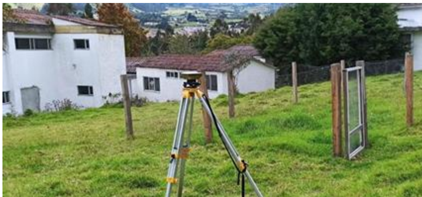
Figura 19 Montaje antena GNSS
