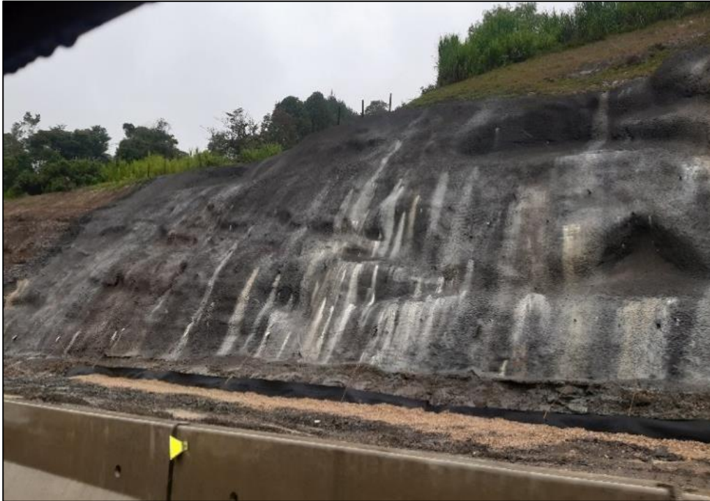
Ilustración 8. Muro de contención
