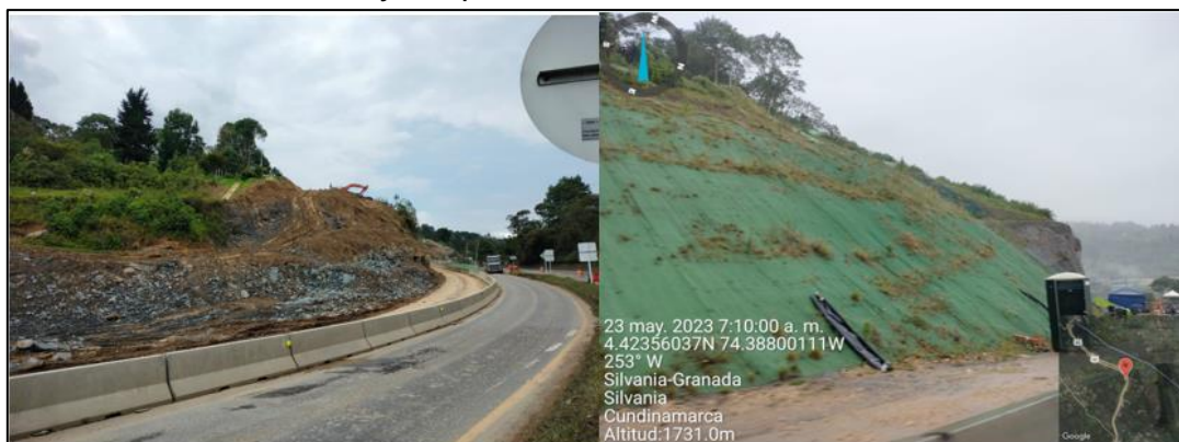
Ilustración 40. Antes y Después Frente de obra en la unidad Funcional 5.
