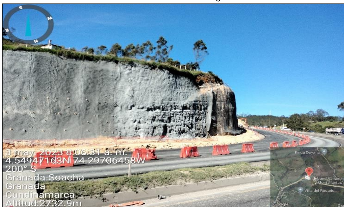
Ilustración 20. Identificación Progreso Obra
