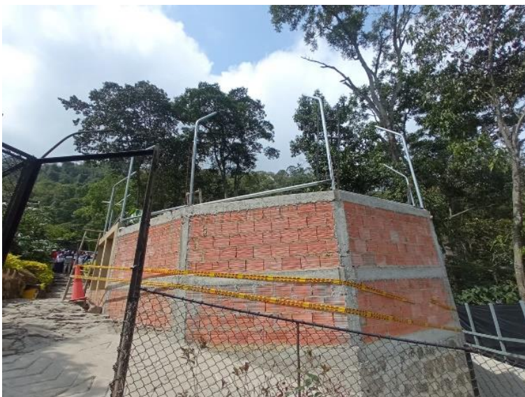
Ilustración 26 Vista frontal de la construcción del nuevo recinto
