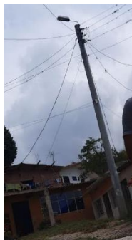
Fig. 40. Instalación de la antena NanoStation M2.
