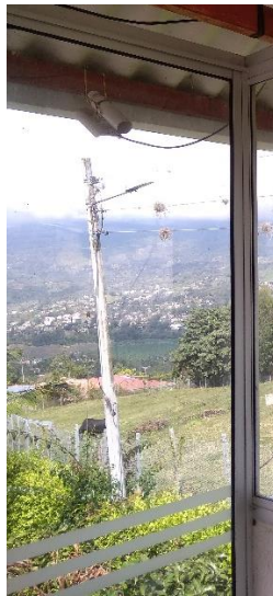
fig. 37. Instalación terminada, nodo Don Jesús.
