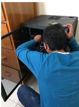
Fig. 53. Mantenimiento gabinete de la dirección de contratación.
