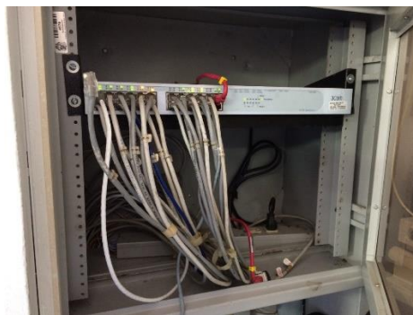
Fig. 54. Mantenimiento gabinete de la secretaria de salud.
