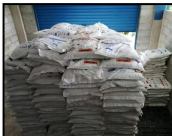
Figura. 34 Salón de dosificación de sustancias
