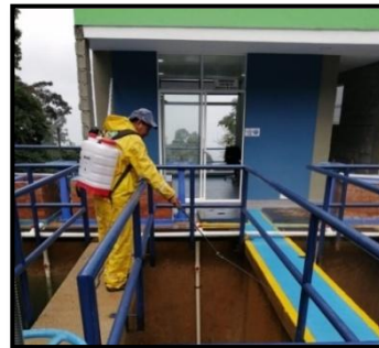
Figura. 49 Fumigación de filtros con hipoclorito de sodio al 10%, planta Pekín. Martínez (2020).
