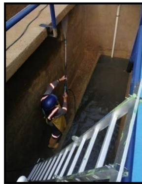
Figura. 47 Lavado de filtros, planta Pekín. Martínez (2020)
