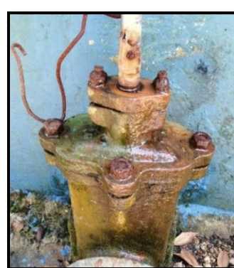
Figura. 15 Accesorios y válvulas hidráulicas con presencia de averías y fugas, planta Pekín. Martínez (2020).
