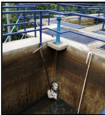
Figura. 14 Avería en válvula de cierre; unidad de filtrado, planta Pekín. Martínez (2020).
