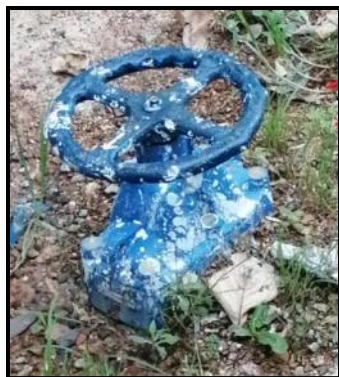
Figura. 15 Accesorios y válvulas hidráulicas con presencia de averías y fugas, planta Pekín. Martínez (2020).
