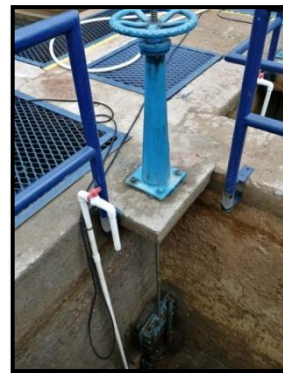
Figura. 48 Válvula de entrada y salida de agua en los filtros, planta Pekín. Martínez (2020).
