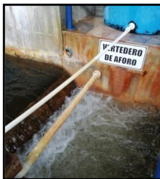
Figura. 32 Vertedero de aforo, planta Pekín. Martínez (2020).
