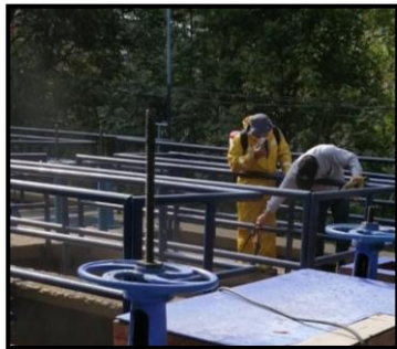
Figura. 49 Fumigación de filtros con hipoclorito de sodio al 10%, planta Pekín. Martínez (2020).
