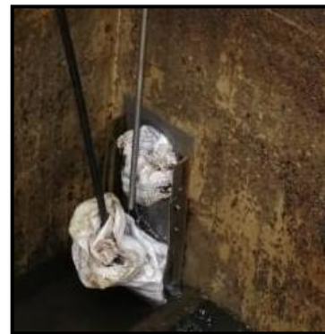
Figura. 14 Avería en válvula de cierre; unidad de filtrado, planta Pekín. Martínez (2020).
