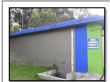
Figura. 12 Tanque de almacenamiento, planta Pekín. Martínez (2020).
