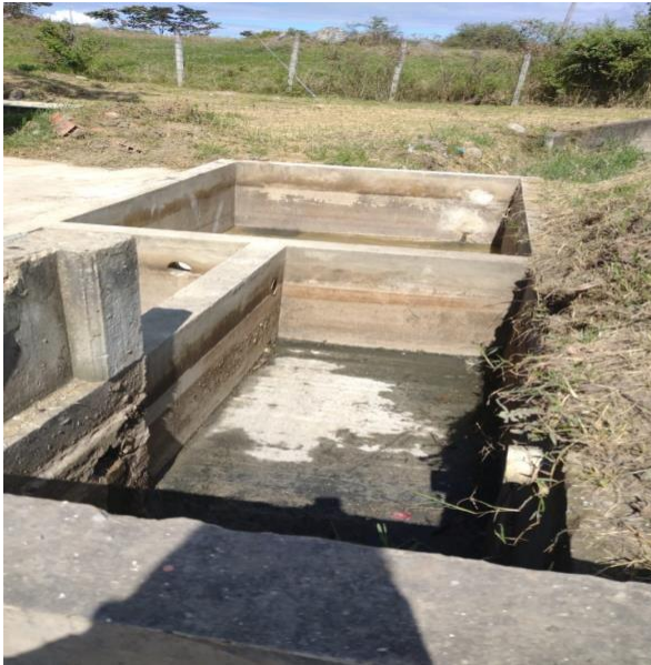
Imagen 4. Caja de Recepción de aguas.
