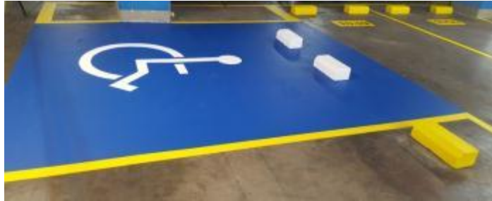
Ilustración 50 Demarcación de parqueaderos personas discapacitadas
