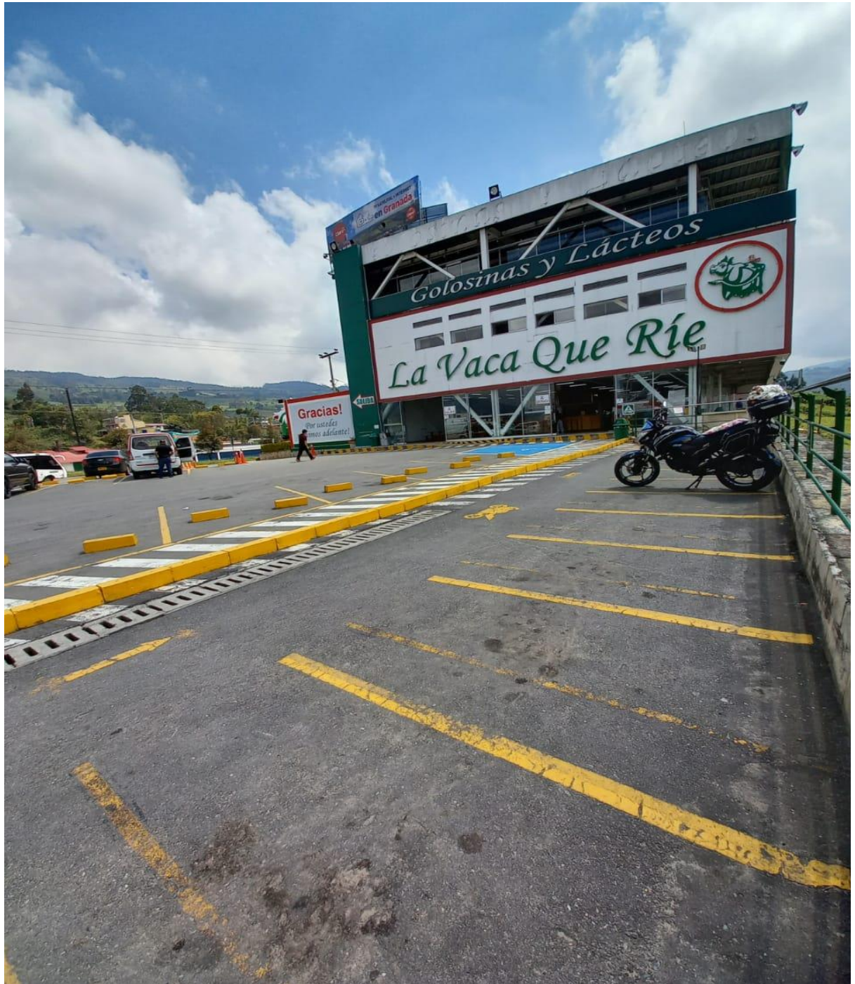
Fuente: MARIA ALEJANDRA PARRA BENITEZ. RECUPERACION TALUD MEDIANTE GAVIONES Y TERRAPLENES.
