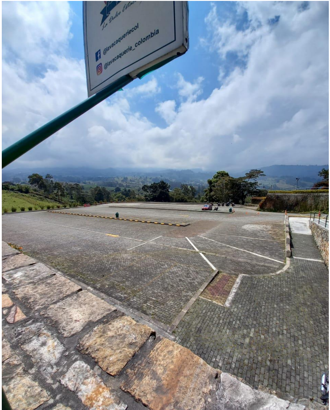
Fuente: MARIA ALEJANDRA PARRA BENITEZ. RECUPERACION TALUD MEDIANTE GAVIONES Y TERRAPLENES.
