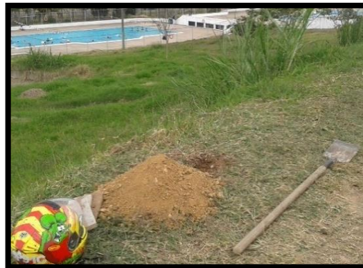
Imagen 8 Excavación mojón GPS2
