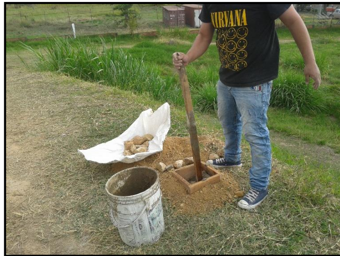
Fotografía . Proceso de excavación GPS-2
