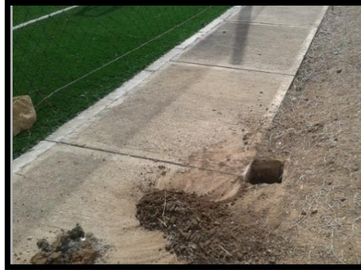
Imagen 7 Excavación mojón GPS1.
