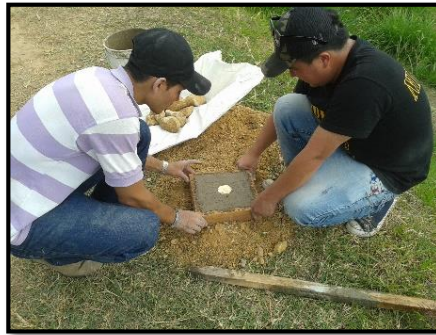
Fotografía . Ubicación de placa y de formaleta
