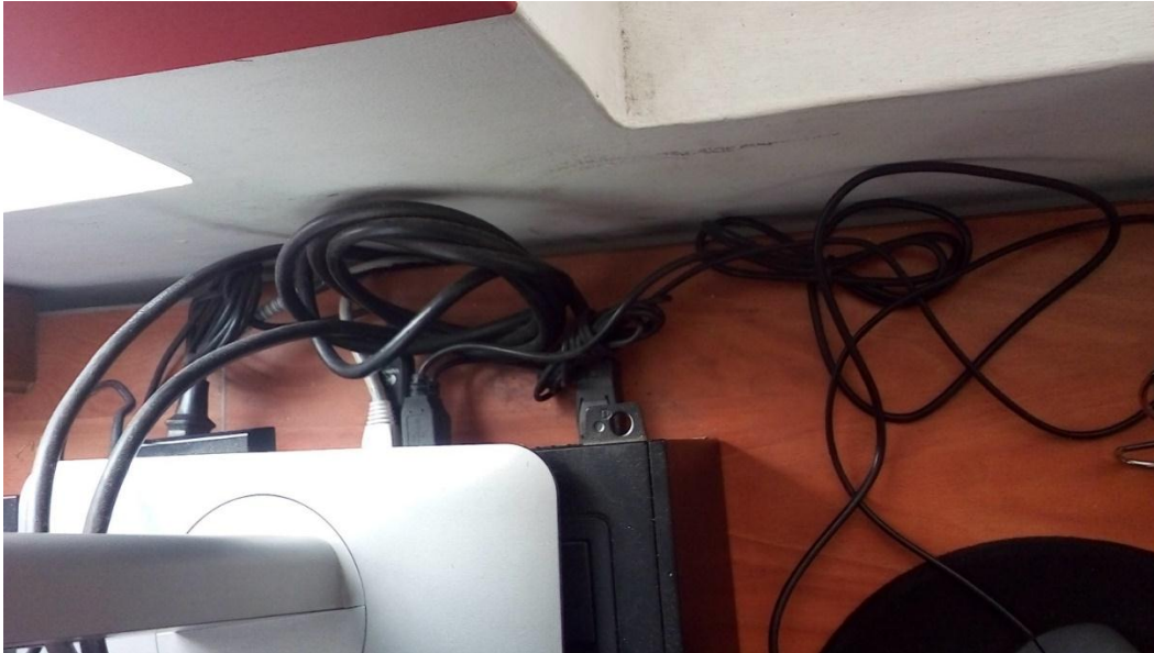
Imagen 28 Puesto de trabajo a realizar proceso arreglo de cableado
