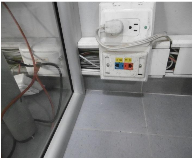
Imagen 5: Puesto de Archivo de Administracion, Area. Administracion.
