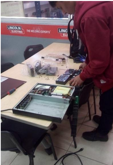
Imagen 5 Mantenimiento Preventivo UPS
