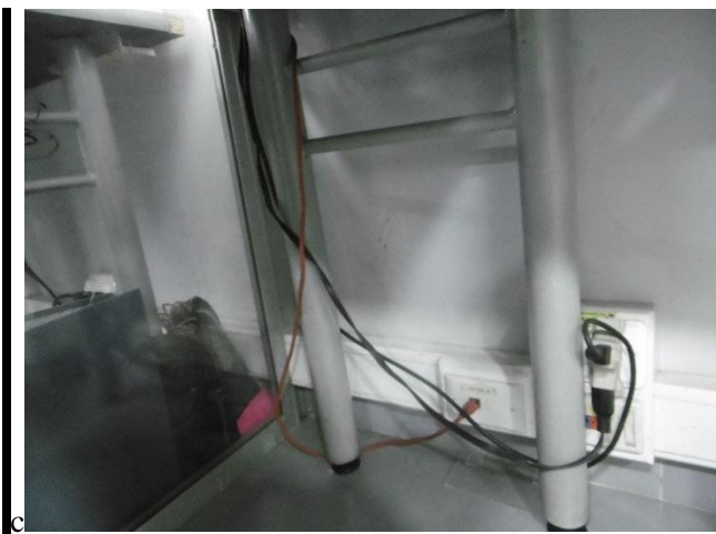
Imagen 1: Puesto: Javier Vergara, Area: Administracion.
