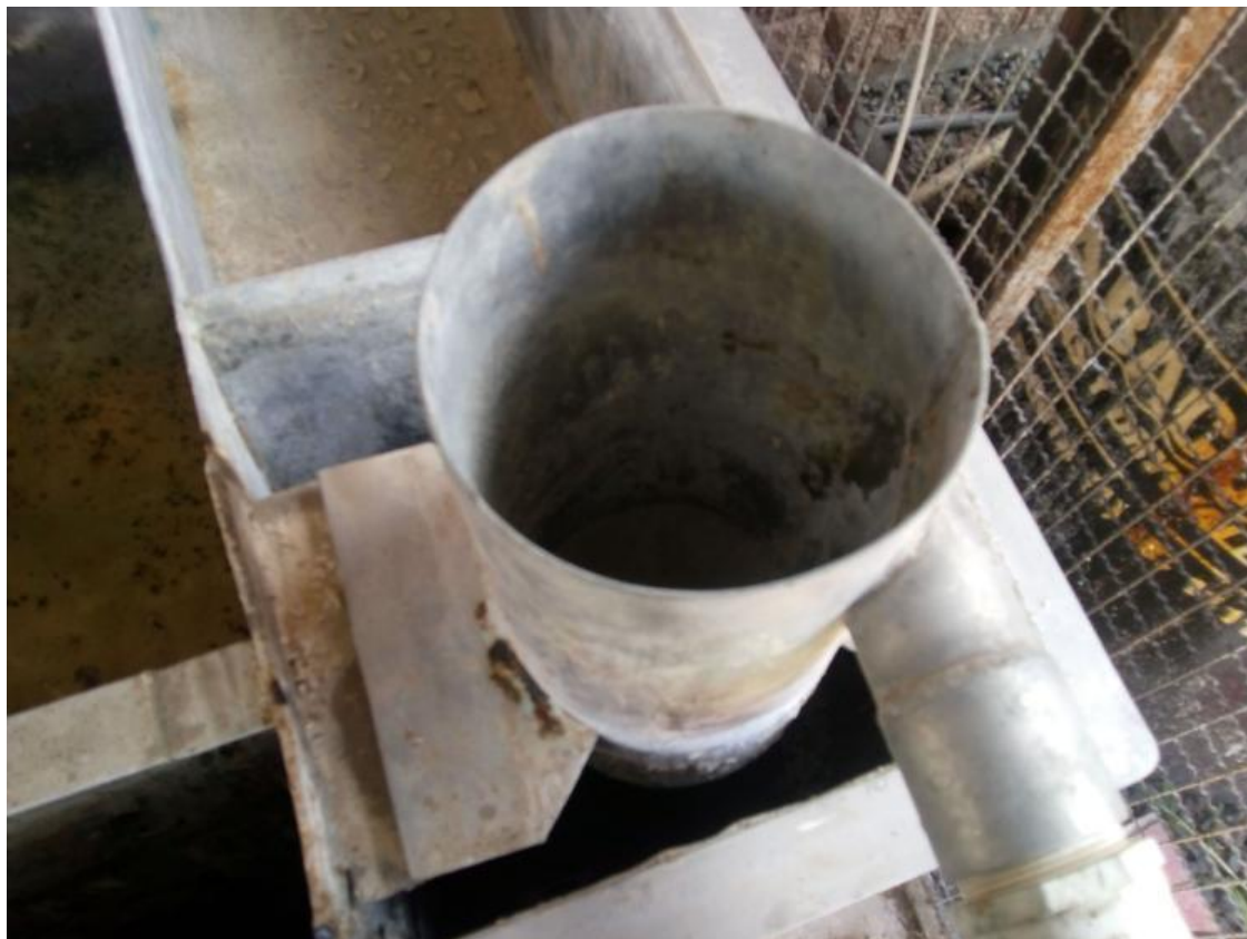
Fig. 14. Cono de mezcla estado actual 2019, Fuente Propia
