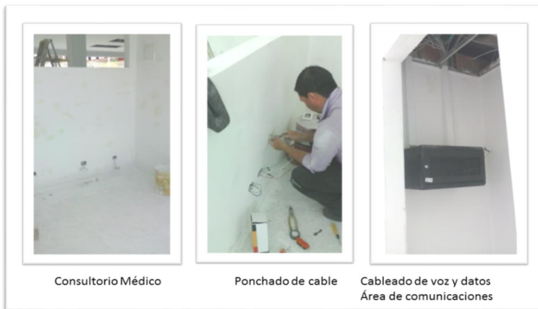
Figura 6. Montaje red de datos centro de salud Sutatausa
