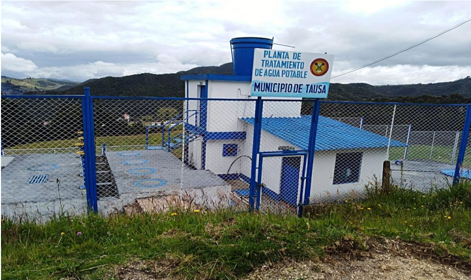
Figura N. 22 Captación Quebrada el Chapetón
