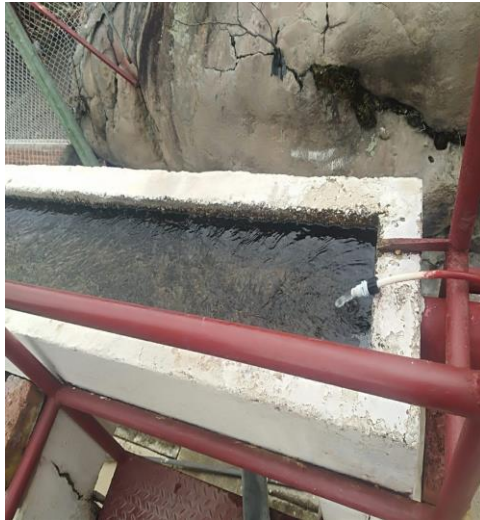
Figura N. 33 Estructura de Entrada
