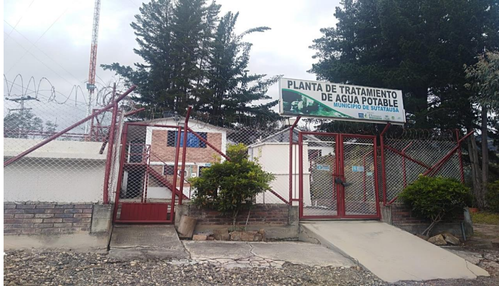
Figura N. 32 Planta de Tratamiento de agua potable municipio de Sutatausa
