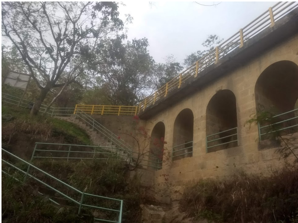
Ilustración 13, Puente Natural, Pandi Fuente: Propia
