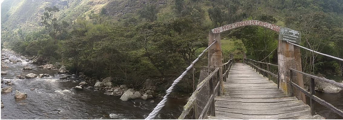
Ilustración 7, Puente profundos en Cabrera Fuente: Propia
