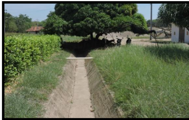
Ilustración 14 Mantenimiento Canal Perimetral
