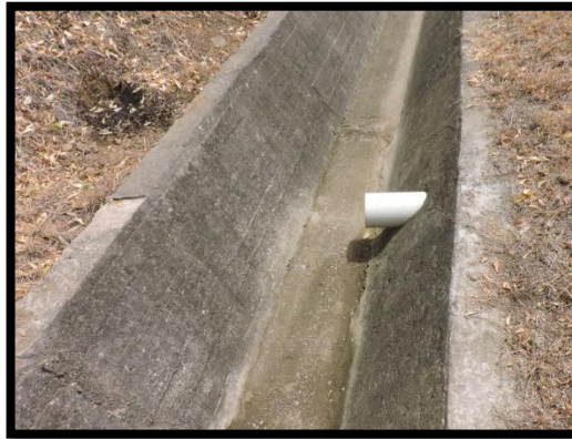
Ilustración 13 Mantenimientos Canal Perimetral
