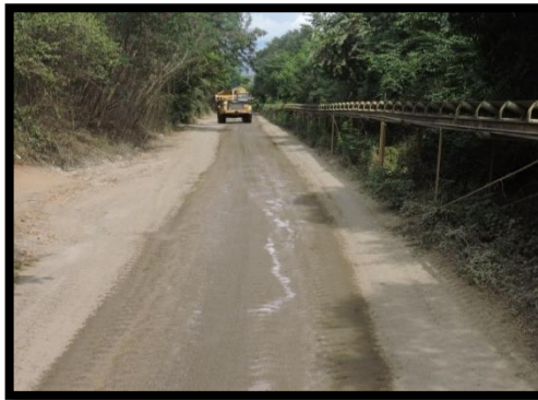
Ilustración 11 Inspección de vías Humectadas.
