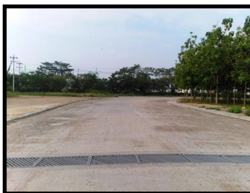
Ilustración 32 Tramo 1 vía pavimentada
