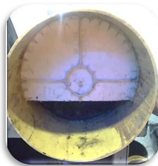
Imagen c. Pantalla pegada en la parte superior del reactor anaerobio, Autoras.
