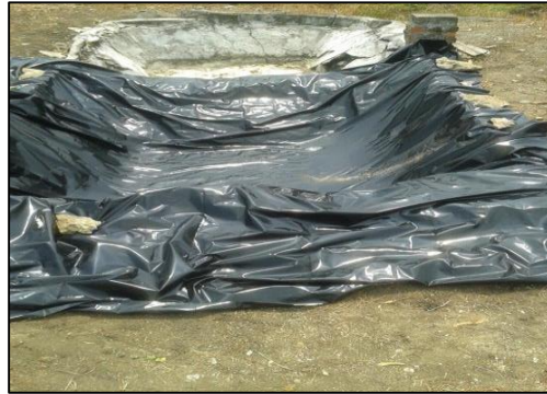
Figura 23: Impermeabilización de la laguna de maduración.
