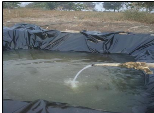
Figura 24: Llenado de laguna de maduración.
