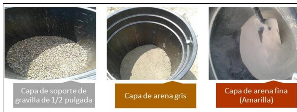
Figura 20: Montaje del lecho filtrante.
