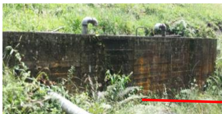
Ilustración 17. Desarenador.
