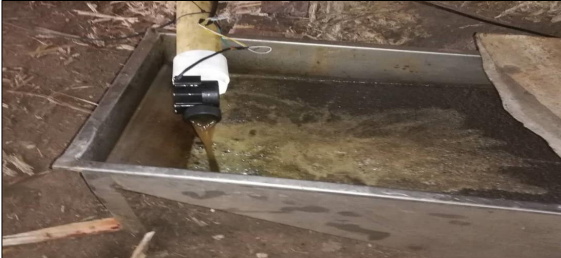
Figura 29. Caudalímetro instalado.
