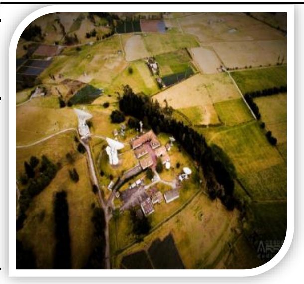
Figura N° 6: Estación Terrena de Comunicaciones y Antenas Parabólicas.
