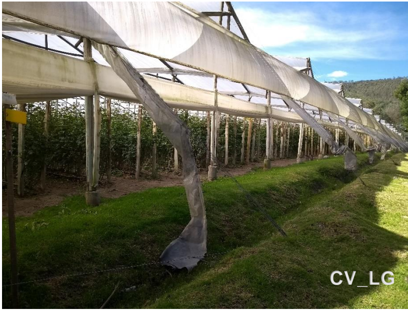
Canales de captación por escorrentía
