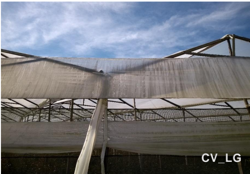
Cortinas y canales de captación de agua lluvia por escorrentía
