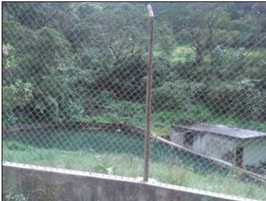
Fotografía 16 Instalaciones acueducto veredal E: 968103,N: 1014558
