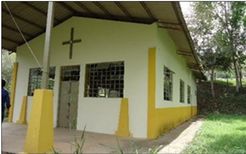
Fotografía 3 Iglesia de la vereda La Honda coordenadas E:960675, N: 961719
