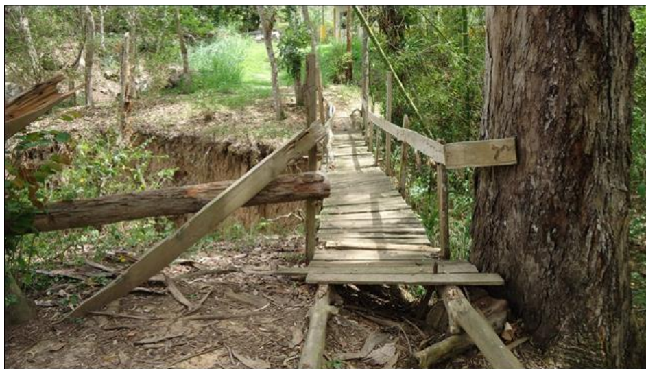
Fotografía 2 Puente sobre la quebrada La Chorrera E: 960648, N: 961731
