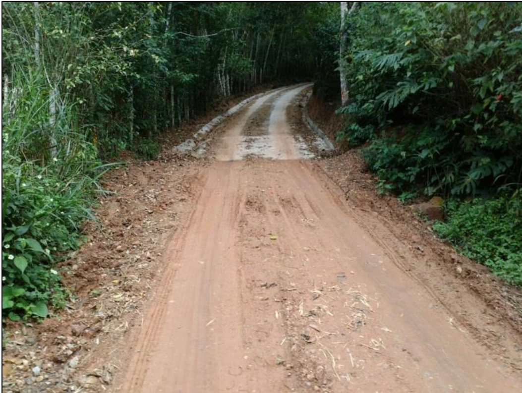
Fotografía 34 . Tramo pavimentado E: 938421, N: 1054922
