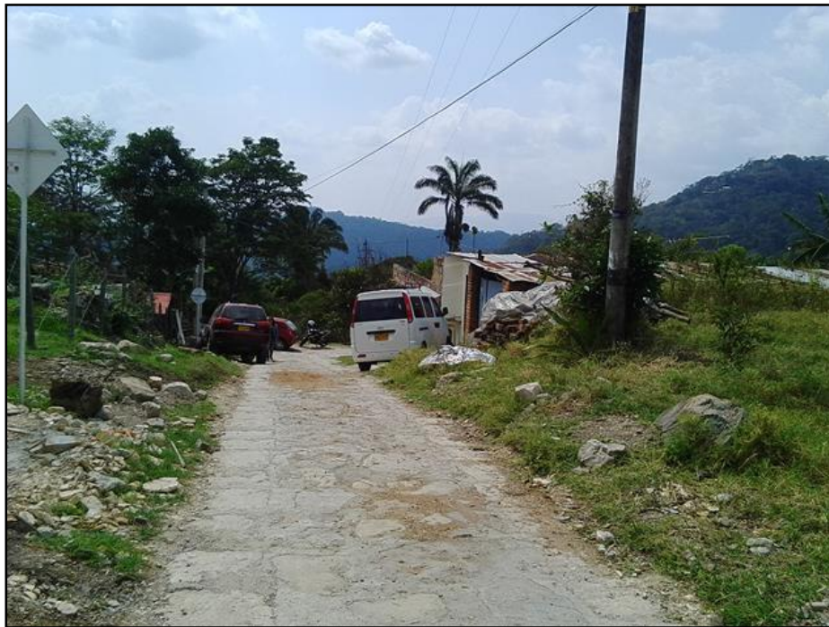
Fotografía 21 Reemplazo del camino de piedra en el caserío E: 962720, N: 1012717
