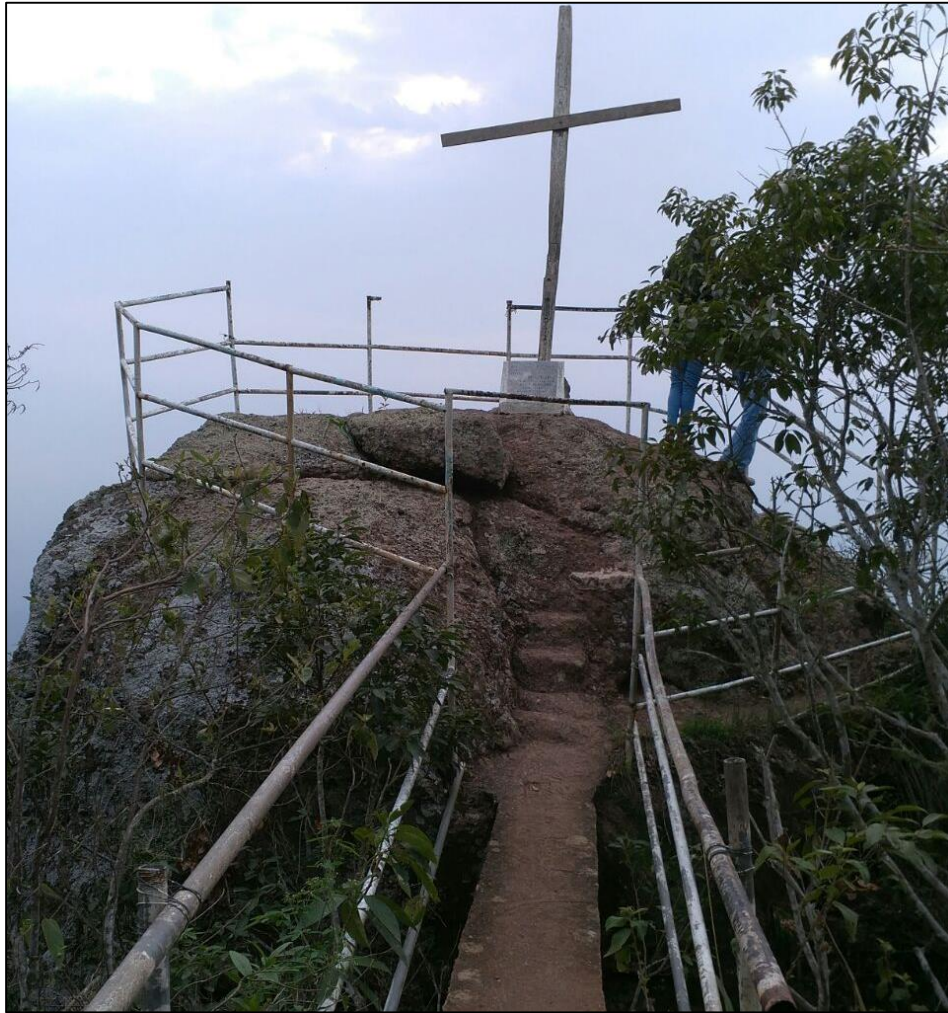
Fotografía 37 El Mirador Piedra Capíra E: 948175, N: 1054643.
