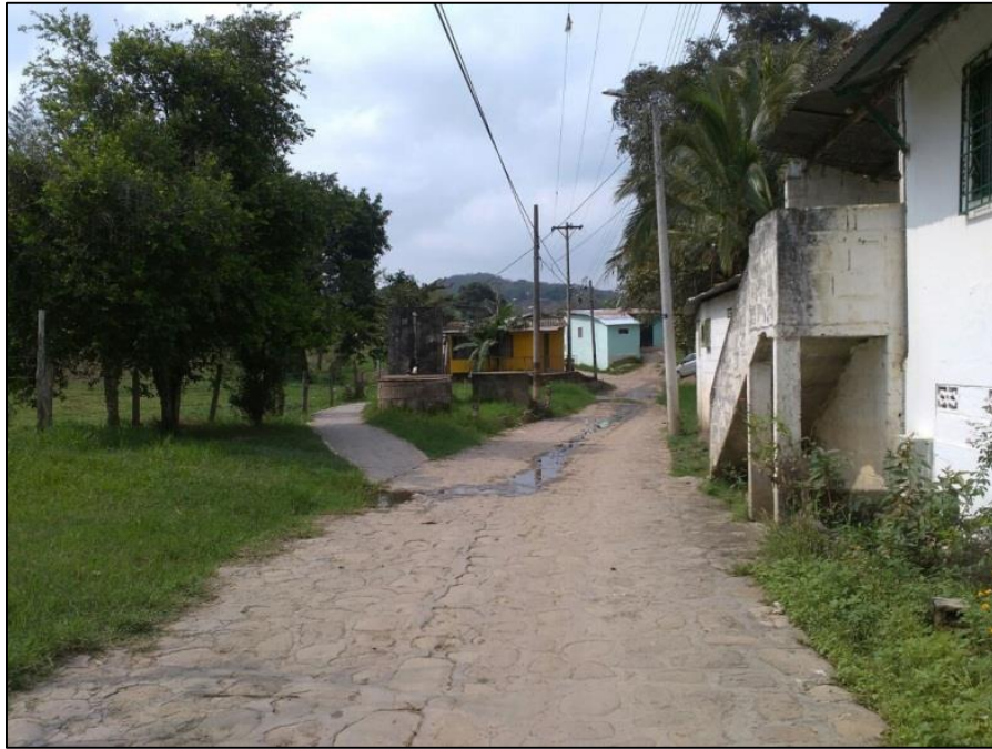
Fotografía 25 . Tanques acueducto y puente peatonal E: 940980, N: 1053494
