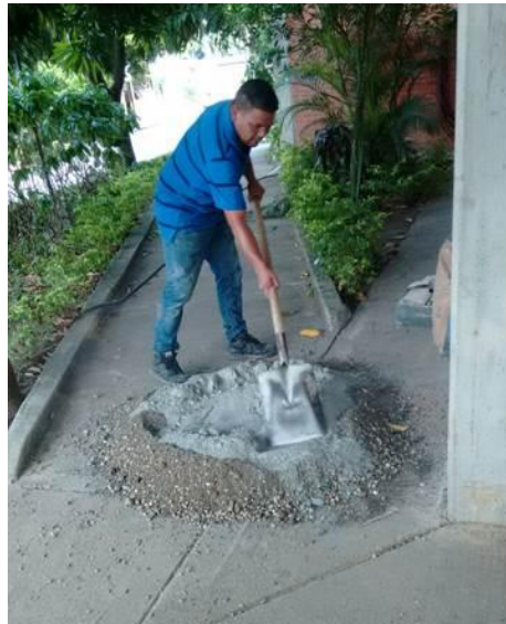
Fotografía 6 Preparación y mezcla del concreto
