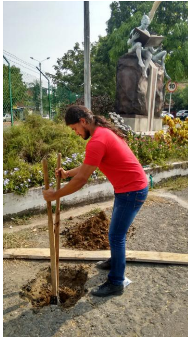
Fotografía 4- Proceso de excavación GPS-1
