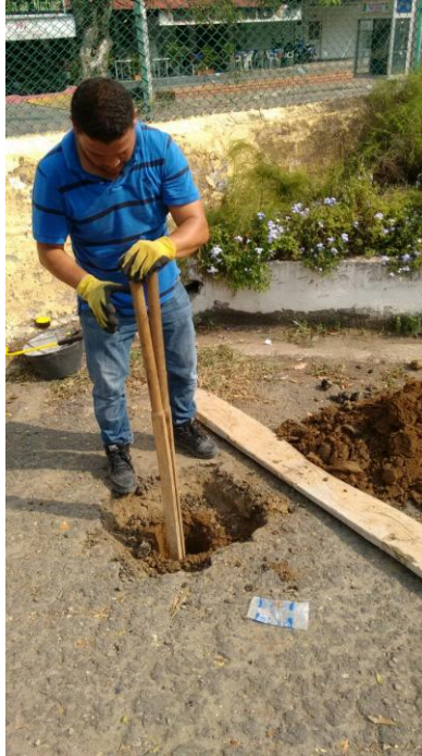
Fotografía 5- Proceso de excavación GPS-2
