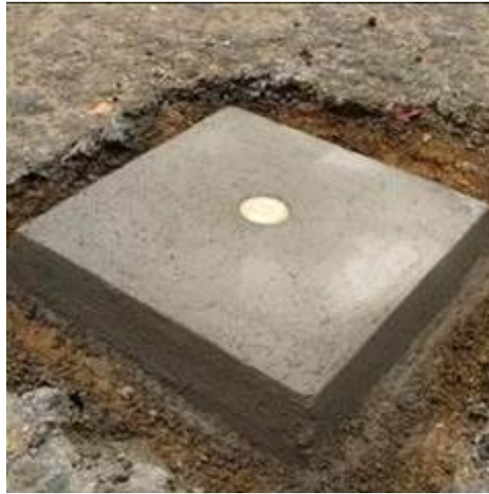
Fotografía 14 Producto final de la monumentación de los dos puntos
