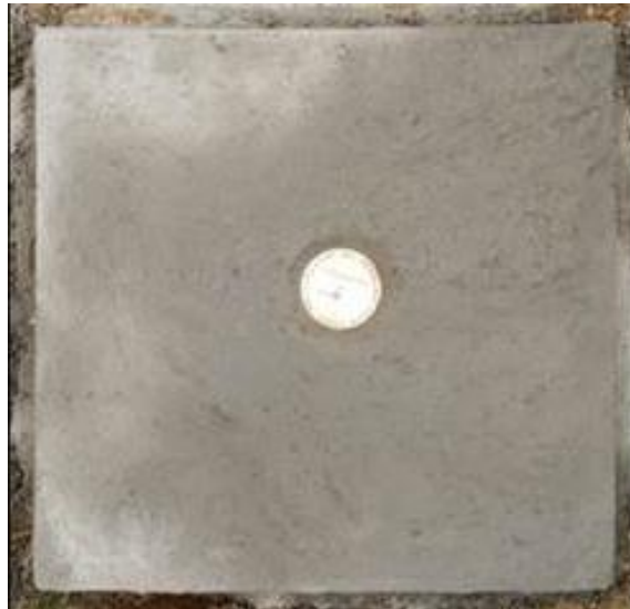
Fotografía 13 Producto final de la monumentación de los dos puntos
