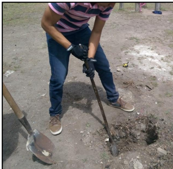
Fotografía 5. Proceso de excavación GPS-2
