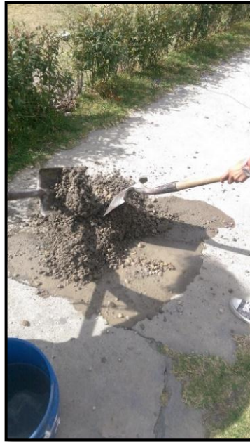
Fotografía 8. Mezcla de concreto
