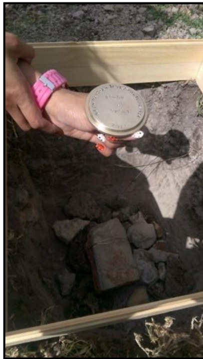
Fotografía 7. Ubicación de placa y de formaleta
