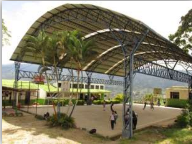
Fotografías 2 Polideportivo de la escuela Bosachoque
