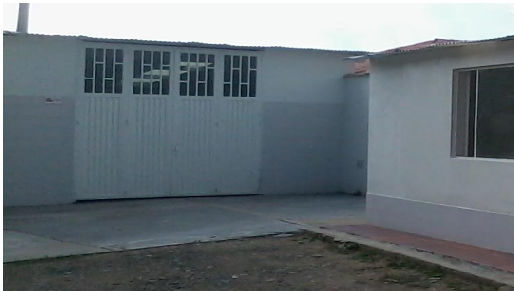
Figura 5. Foto Entrada Al Área De Proceso (Antes)
