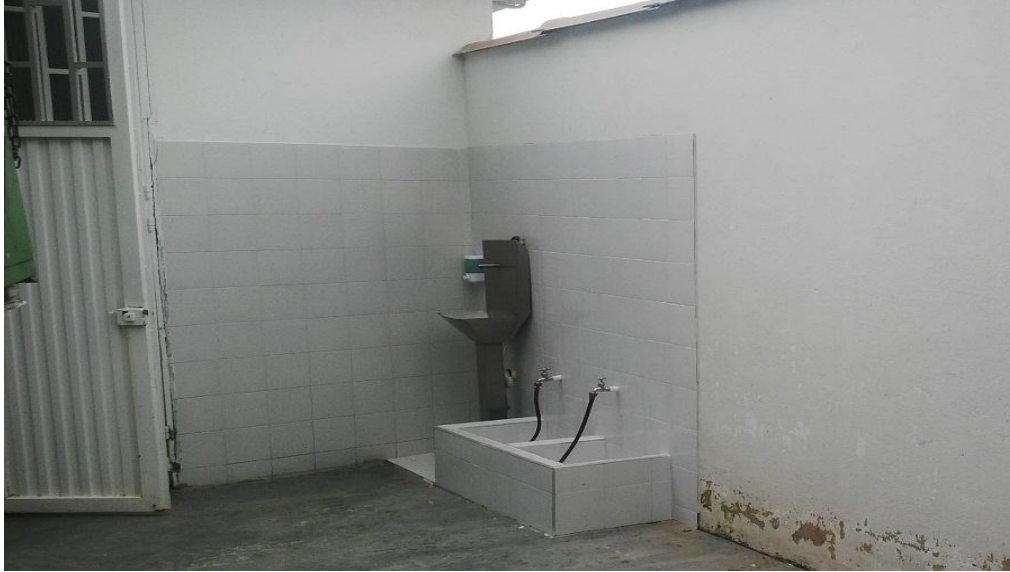
Figura 6. Foto Entrada Al Área De Proceso (Después)
