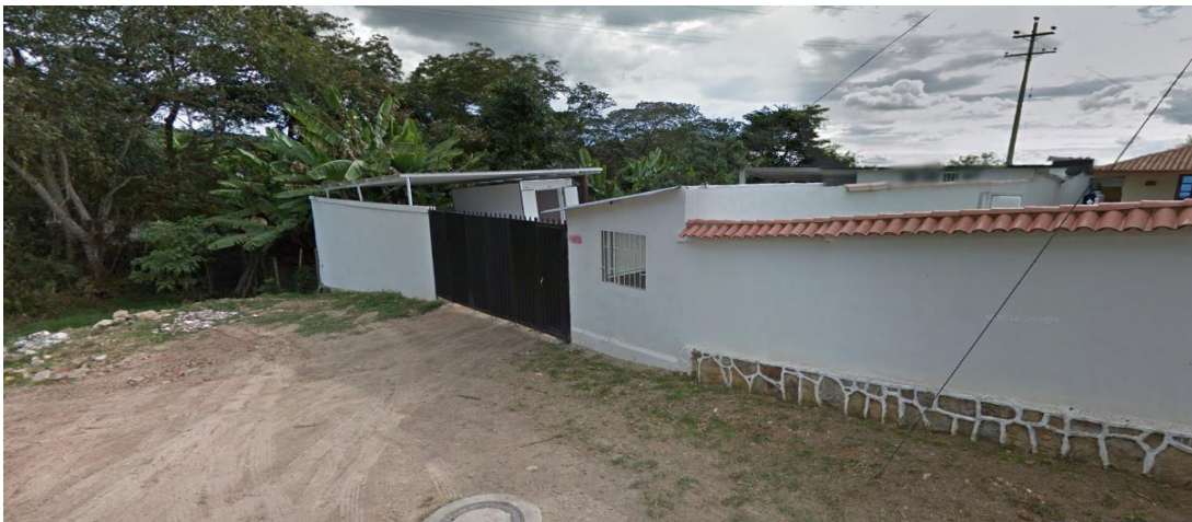
Figura 2. Fachada Planta de Beneficio Avicola “Criollo Criollo”
