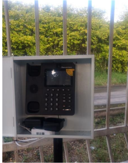
Figura 33 Instalación del segundo Teléfono Volp (Autor)
