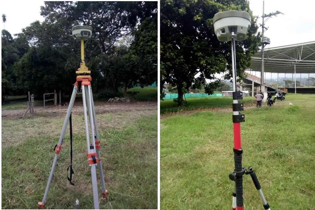
Fotografía 3 Cuadrando las antenas con la estaca georreferenciada.
