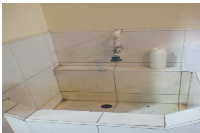
Ilustración 14. Punto de recolección de aguas residuales de la compañía
