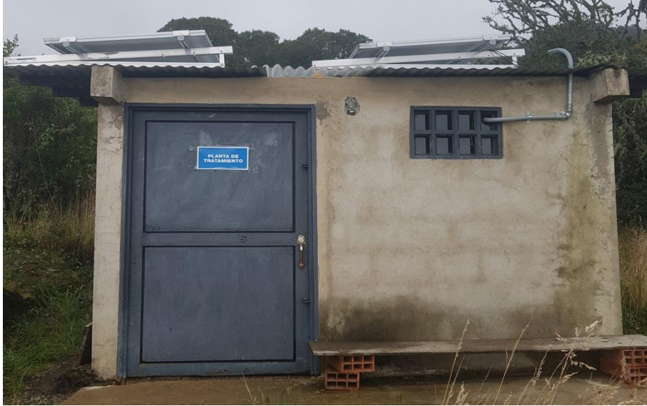
Ilustración 5. Planta de tratamiento del acueducto veredal Acuepiedraparada.
