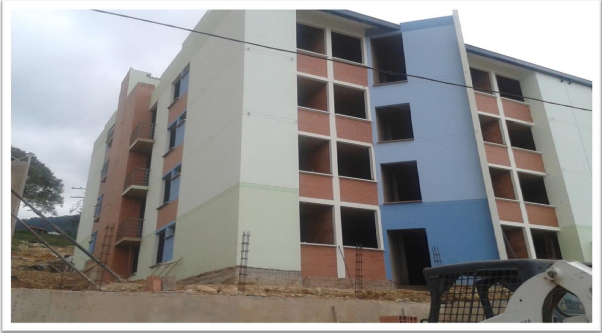
ANEXO F. Fotografía visita a la Etapa III del Conjunto La Palma.
