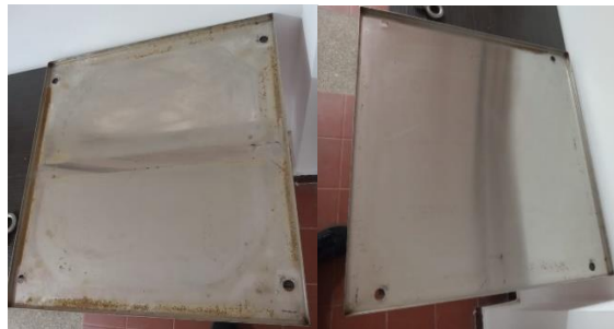
Figura 43. Tapas del chasis antes y después del mantenimiento. (Fuente: elaboración propia.)
