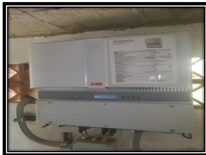
Ilustración 14. Medidor paneles Universidad de Cundinamarca
