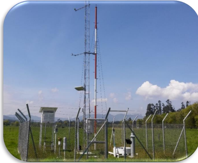
Figura 22. Estación climatológica principal, Novilleros- Ubaté. Fuente: (Duarte, 2019)
