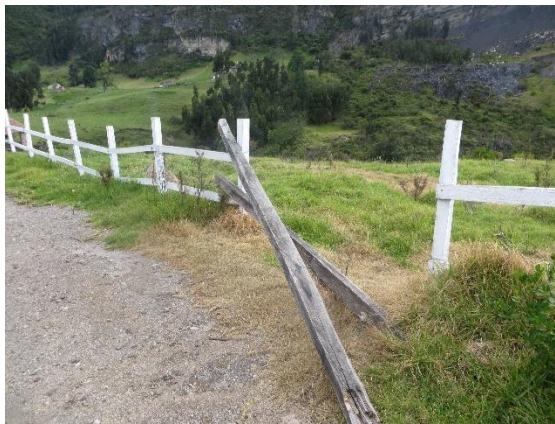
Ilustración 30 Deterioro de cercas Fuente: Autores
